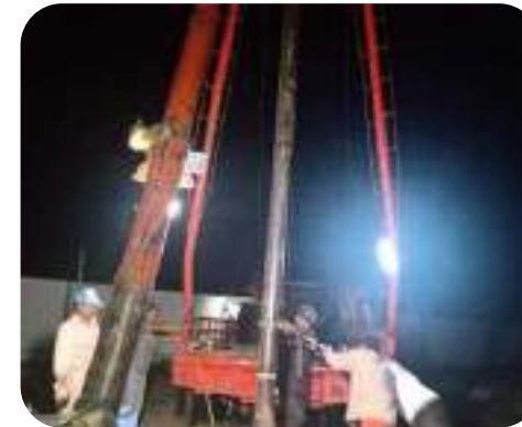
Mantenimiento correctivo a pozo de agua (2023)
