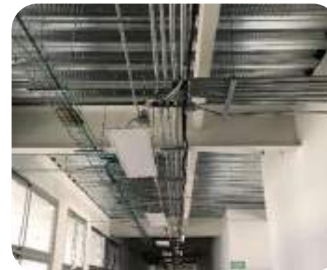
Construcción de canalización para voz y datos en el tercer piso del edificio principal (2023)
