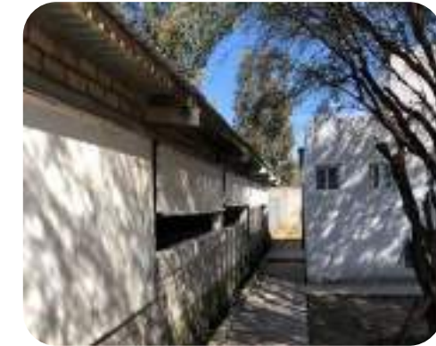
Acceso e instalaciones en granja de cerdos (2023)
