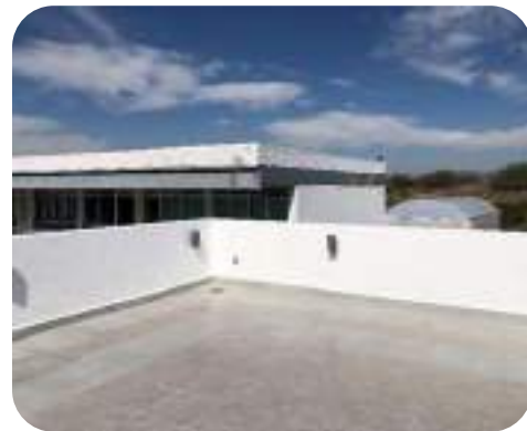
Rehabilitación de terraza y auditorio (2026)
