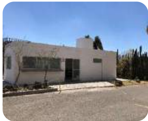
Jardín Botánico (adecuaciones y remodelación)
