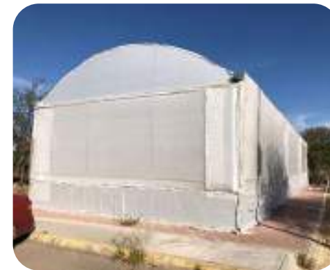
Construcción de plataforma para invernadero del Cuerpo Académico de Biotecnología y Sanidad Vegetal (2024)
