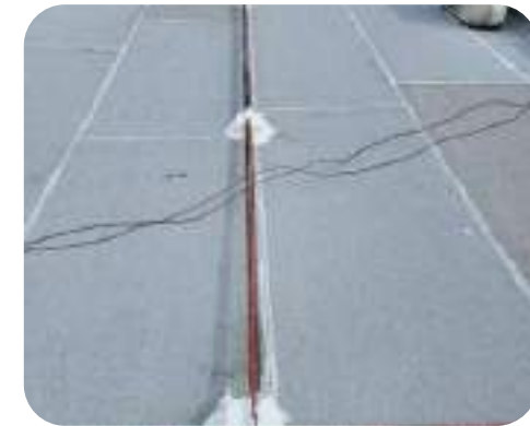
Reparación de losa de la azotea del edificio de laboratorios UMBA's (2025)
